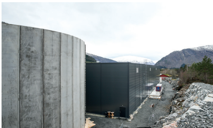
Biogassanlegget sett fra baksiden mot nord.
