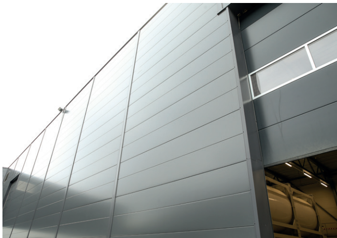
Selve bygget med reaktorer er et typisk stålbygg med isolerte stålsandwichpaneler som vegger. GH Prosjekt har levert stålkonstruksjonene på fasaden.
