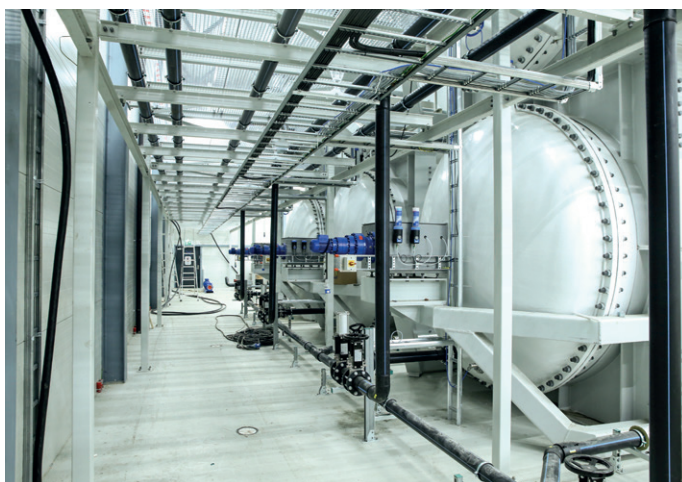
På innsiden er det høyteknologisk prosessutstyr for omdanning av kumøkk, fiskerester og matavfall til biogass.
